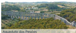
Aqueduto dos Pegões
